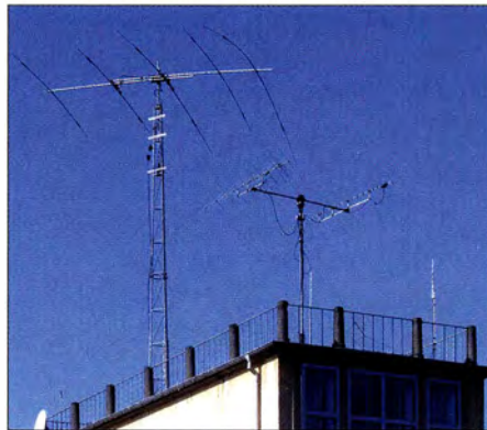
KW-Beam und 2-m/70-cm-Kreuzyagi-Antennen auf einem Antennenturm des nach Prof. Dr. Heinrich Barkhausen benannten Gebäudes der TU Dresden Foto: DL2DVL
