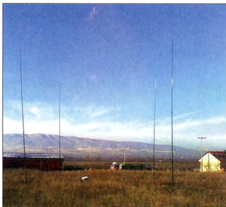
Das 4-Square-Array fürs 40-m-Band aus Glasfasermasten war bereits bei diversen DXpeditionen im Einsatz und bewährte sich nun auch bei der Z60WW-Aktivität. Fotos: DL3DXX, OH2BH (1)
